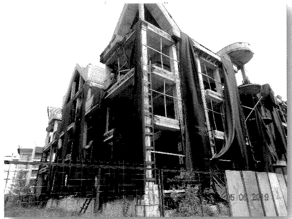
Cladirea este executata pe cadre de b.a.aflate in stare f. avansata de degradare deoarece la momentul sistarii lucrarilor de executie ( 1993-1994) nu au fost executate lucrari de conservare a structurii.
