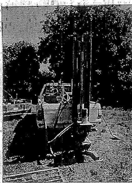
Foto 1. Aspectul terenului investigat și instalația de foraj geotehnic Pride Mount 20 utilizat.
