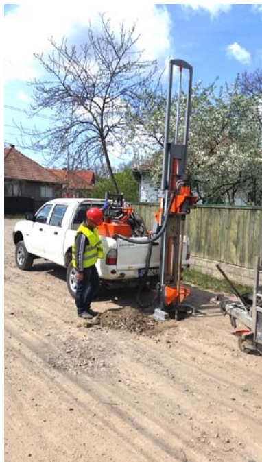
Foto.2. Aspectul terenului de fundare studiat și instalația de foraj geotehnic Pride Mount 20 folosit.
